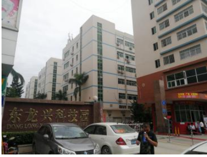
东龙兴科技园
