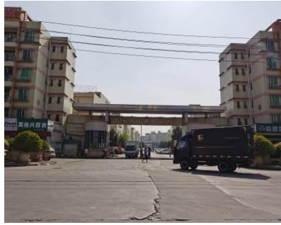
蚝四南浦科技工业园
