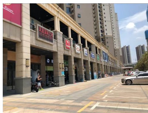
融湖中心城一期（南侧支路）
