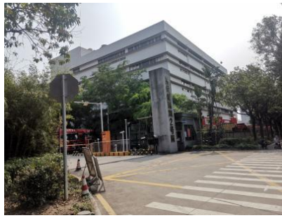
易代储深圳 2 号院
