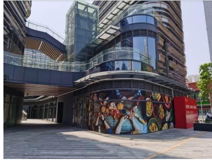
盛迪嘉海湾里大厦（裙楼）
