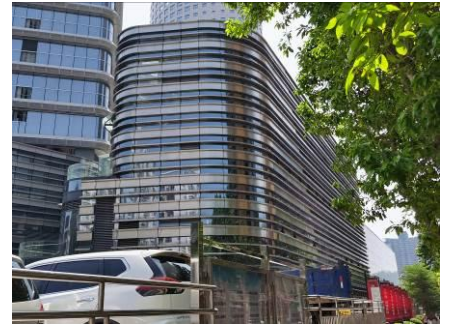
盛迪嘉海湾里大厦（裙楼）
