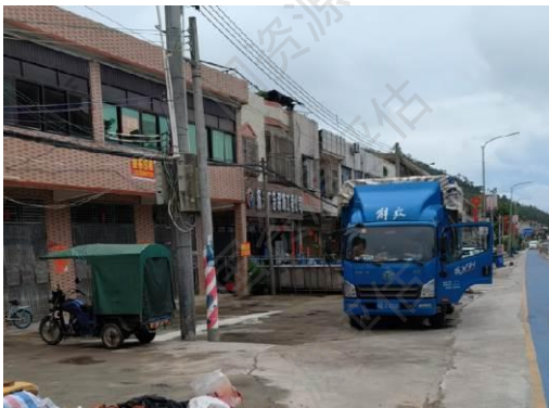
丹东线东段民房临街商铺
