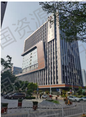
深业泰然雪松大厦
