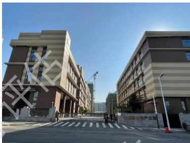
冠恒新材料产业园（一期）
