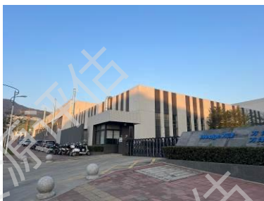
万泽航空科技（深汕）厂区（一期）
