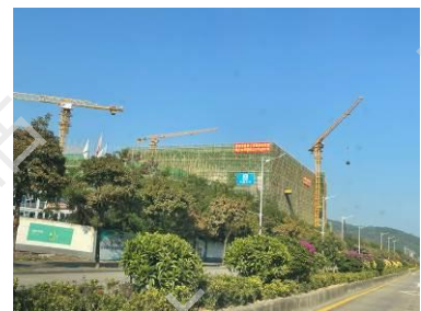
小漠港商贸物流园（一期）（在建）
