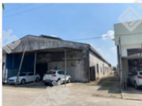
大岗镇北龙路独院厂房
