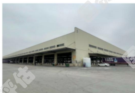
大岗镇工业区高台仓厂房
