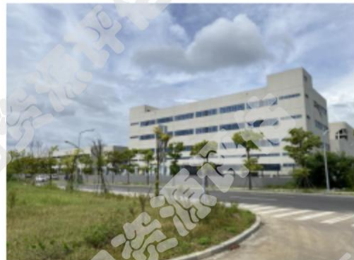
大岗南沙交投先进智造产业园等新建厂房
